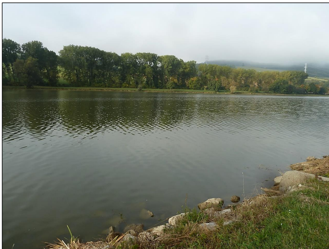
Obr. 2: Pohľad na vodnú nádrž Čereňec
